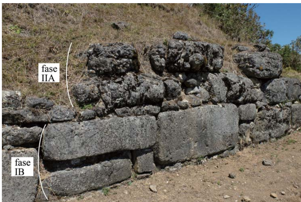
Figura 18 El muro de contención que sostiene la Tercera Plataforma. Los materiales pétreos de la parte inferior fueron colocados en la subfase IB, mientras que los de la parte superior lo fueron en la subfase IIA. ©Proyecto Arqueológico Pacopampa
